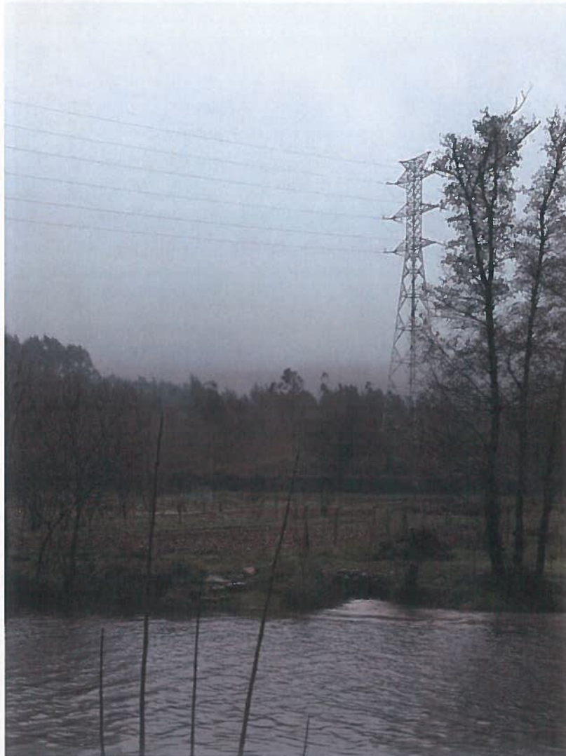
Fotografia 1 – Passagem da Linha pelo rio Ave (vão 33/47 a 34/46), com BFD (1)
