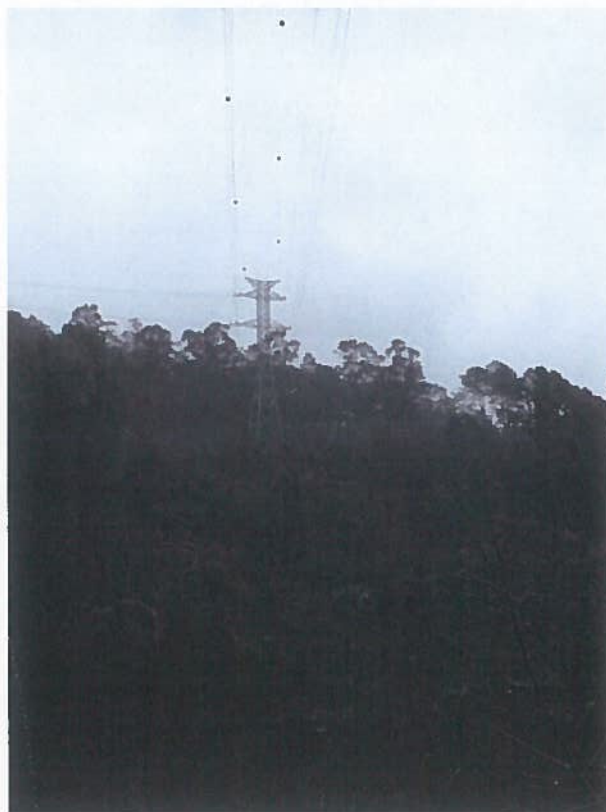
Fotografia 8 –Vão 73/7 a 74/6, com balizagem aérea e sinalização com BFD (1)
