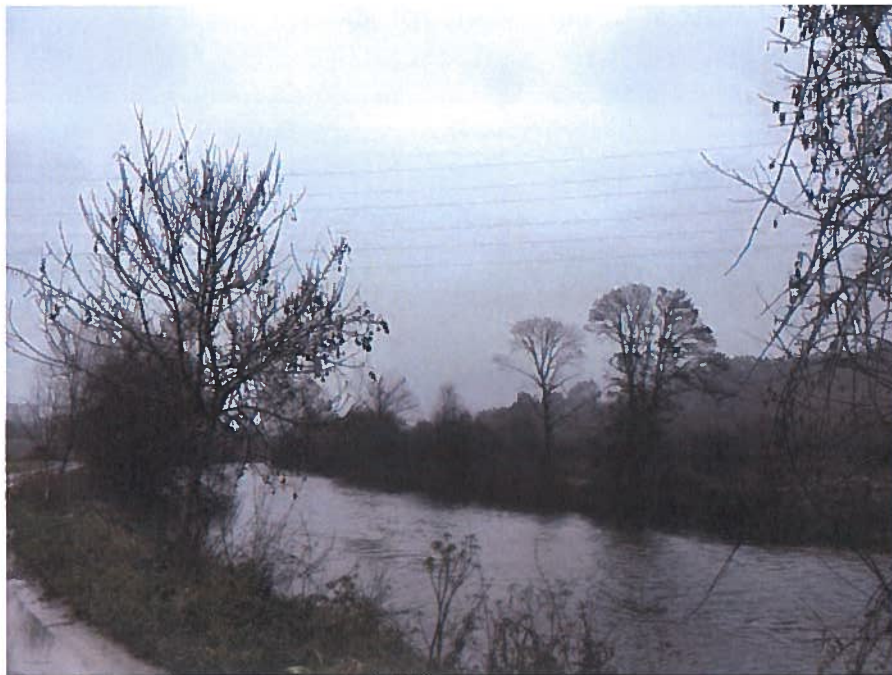
Fotografia 2 – Passagem da Linha pelo rio Ave (vão 33/47 a 34/46), com BFD (2)
